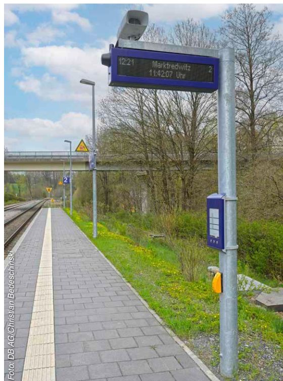
Dynamischer Schriftanzeiger (zweizeilig) mit Informationstaster und DAB des Bf Reuth
