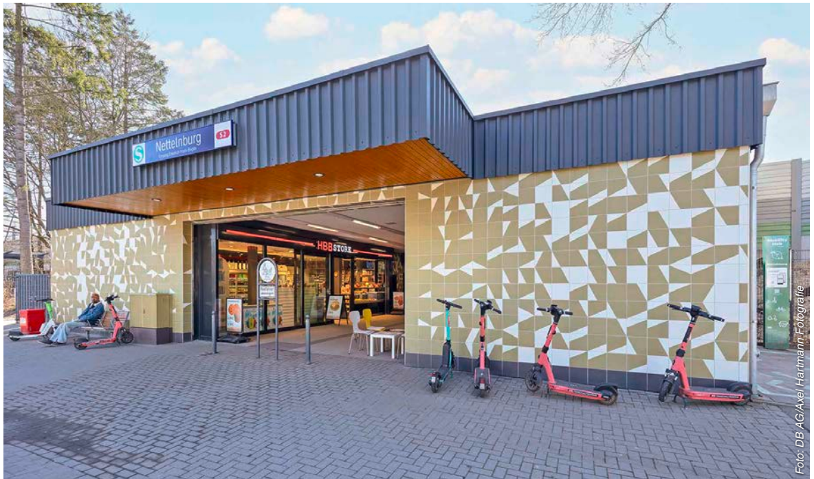
Modernisiertes Zugangsgebäude Bahnhof Nettelburg, Regionalbereich Nord
