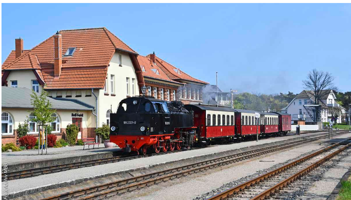
Teilsaniertes Bahnhofsgebäude (2020). Noch fehlt das Fachwerk am historischen Giebel von 1911
